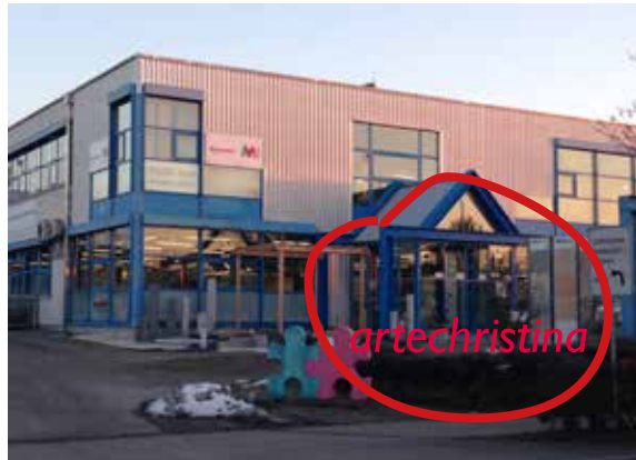
Gebäude Richner Baubedarf Haupteingang
